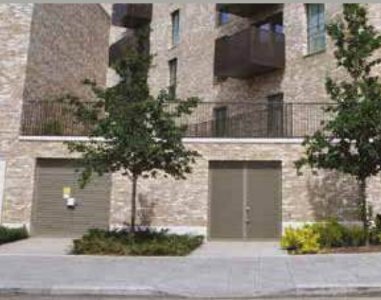
Technische ruimtes onderdeel van architectonische compositie
