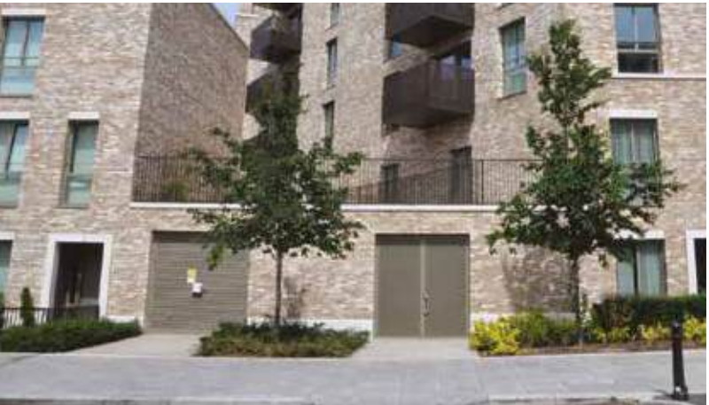
Technische ruimtes onderdeel van architectonische compositie
